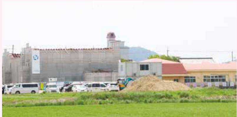
左側が建設中の園舎。右側が現在の園舎。 新園舎完成後は旧園舎は解体され、園庭等に整備されます。
