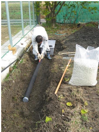
土壌処理用のトレンチ敷設工事
